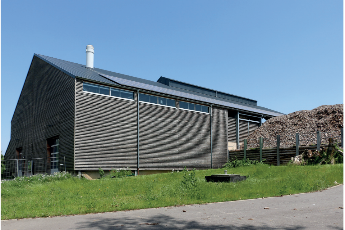
Panneaux photovoltaïques en copropriété sur la toiture de l'équipement : donner l'exemple aux habitants
