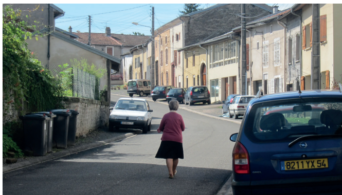
AVANT travaux : une route perméable destinée aux voitures
