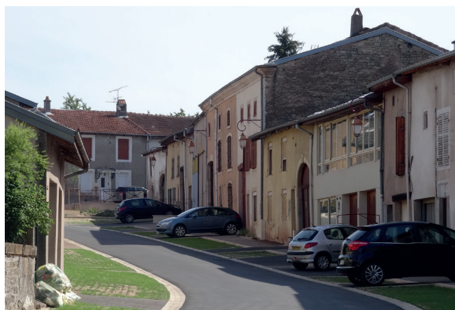
APRES travaux : un lieu de vie partagée
