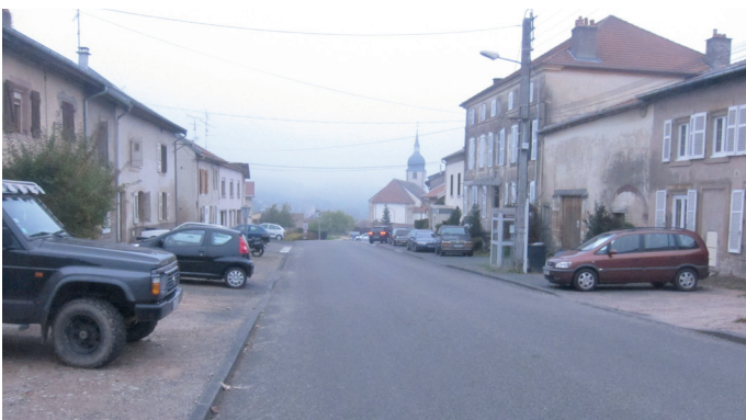
AVANT travaux : une rue imperméable dédiée à la voiture
