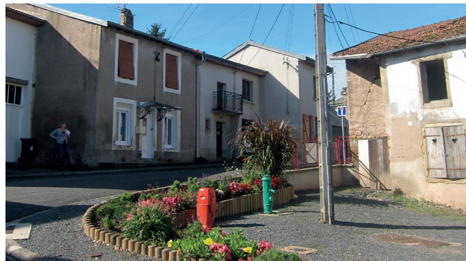
AVANT travaux : un espace encombré
