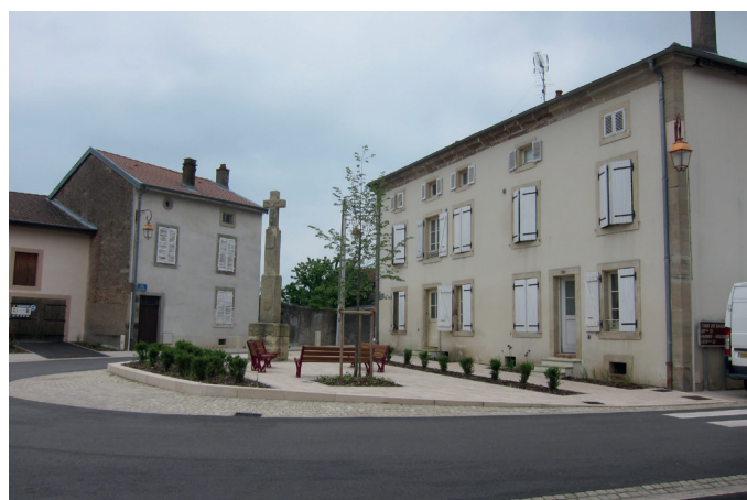
APRES travaux : une vaste zone de vie
