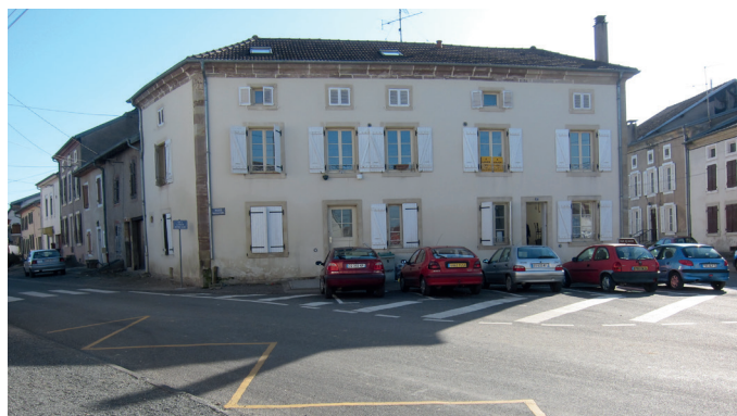
AVANT travaux : Une place impermeable dédiée au stationnement
