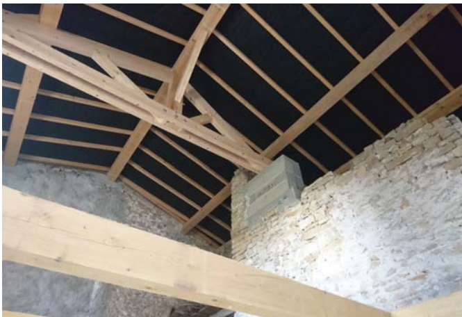
Toiture isolée par l'extérieur, frein vapeur visible côté intérieur Photo de Benjamin DARBOT et Jérémy LEVILLAIN
