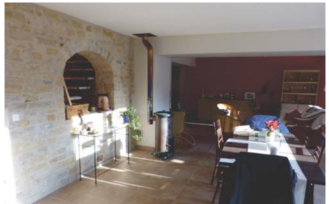
Intervention sur un mur porteur dans une maison à FORCELLES-ST-GORGON Photos de David PELTRE et Guillermo KÖHLER
