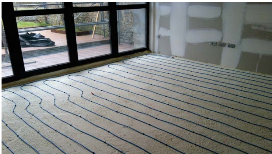
Installation d'un plancher chauffant électrique à ST REMIMONT Photo de Cécile VAUBOURG et Michèle VIDAL
