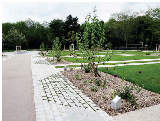
Traitement du pluvial par infiltration, cimetière de Montigny-le-Bretonneux (78) Paysagiste concepteur Arc -en-Terre
