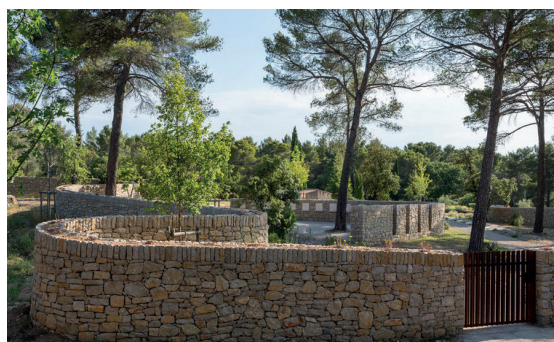
Mur d'enceinte en pierres naturelles de l'extension paysagée du cimetière de Saint-Marc-Jaumegarde (13). Equipe Frédéric Gimmig, David Mossé, Reliefs Paysagistes
