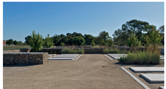
Alcôve en murs de gabions au nouveau cimetière de Beausoleil-les-Sorinières (44) © Atelier architecture Philip Madec
