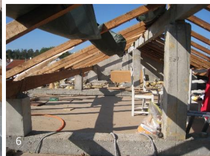
Photos d'un chantier avant la mise au point du procédé de caissons Les montants de bois en "I", sont fixés aux façades et à la poutre faîtière en toiture.
