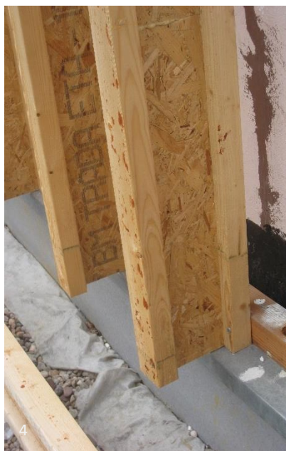
Photos d'un chantier avant la mise au point du procédé de caissons Les montants de bois en "I", sont fixés aux façades et à la poutre faîtière en toiture.
