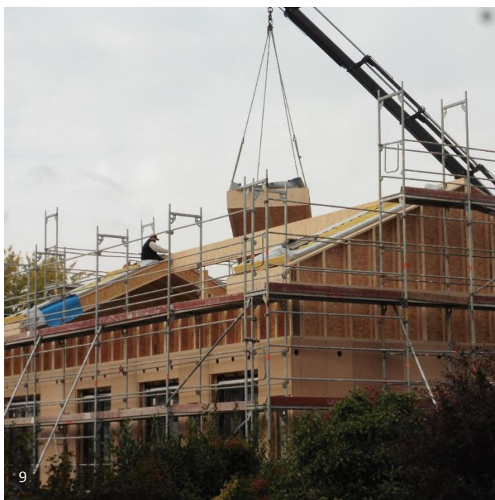
Photos du premier chantier réalisé avec les caissons de la coopérative
