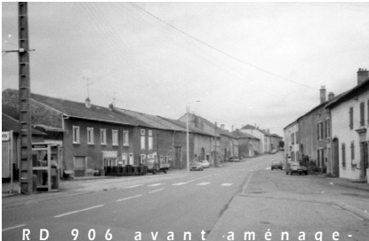
RD 906 avant aménagement
