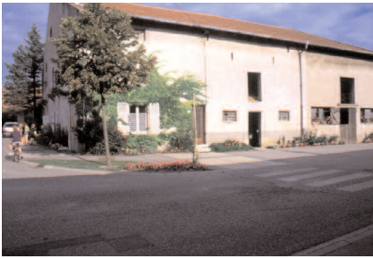
Aménagement des usoirs au niveau du carrefour
