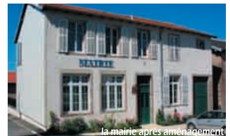
la mairie après aménagement
