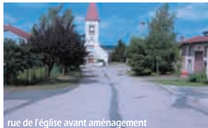
rue de l'église avant aménagement
