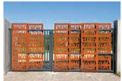
Le portail d'entrée vue de l'extérieur
